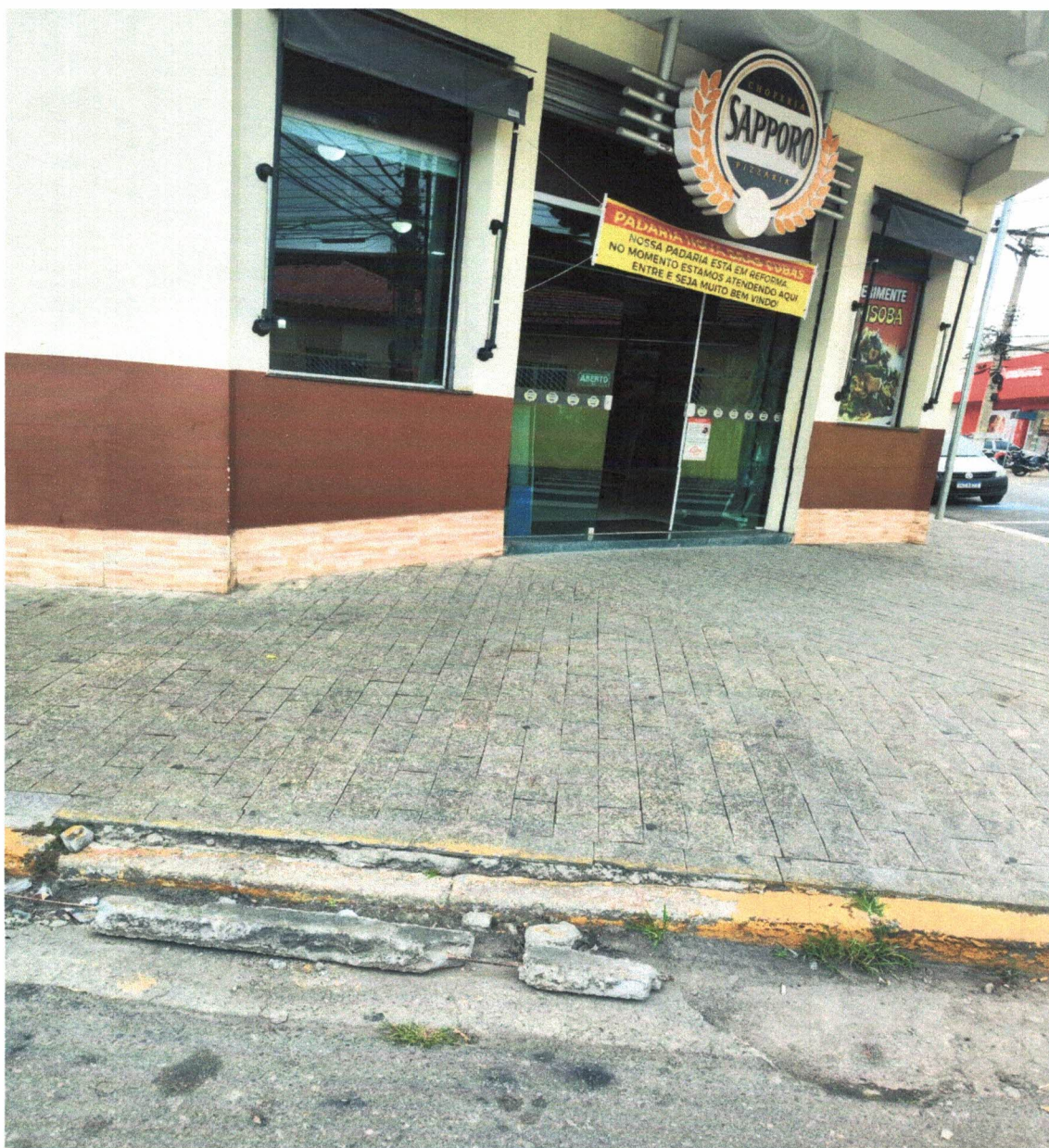
REPARO DE GUIA LOCALIZADA NA RUA PADRE ALVARO QUINONEZ ZUNIGA Nº151, BRAS CUBAS – MOGI DAS CRUZES.
